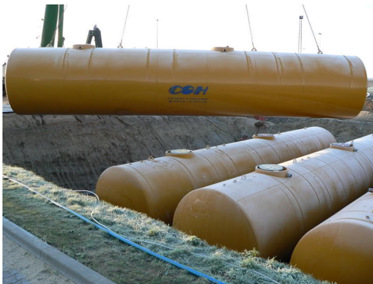
4 x 100 m 3 dobbeltvægede jordtanke til transportcenter
